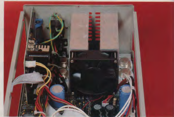
La carte GPIB-contrôle placée verticalement et le tunnel d'évacuation thermique.
