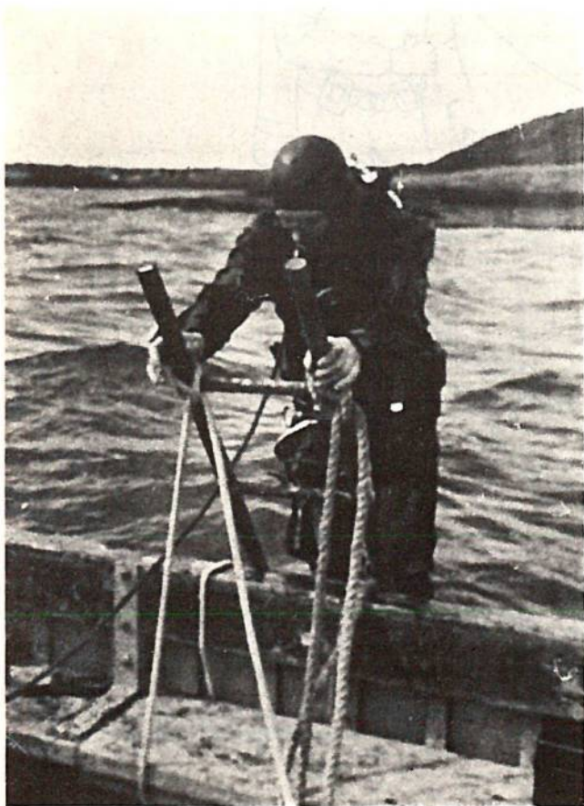
2. Ce scaphandrier prépare l'immersion du tuner qui, guidé par des cordages, va aller rejoindre l'équipe déjà au travail. Il subviendra ensuite aux besoins du tuner en électricité en pédalant sur la génératrice. (Photo Sotraplex.)
