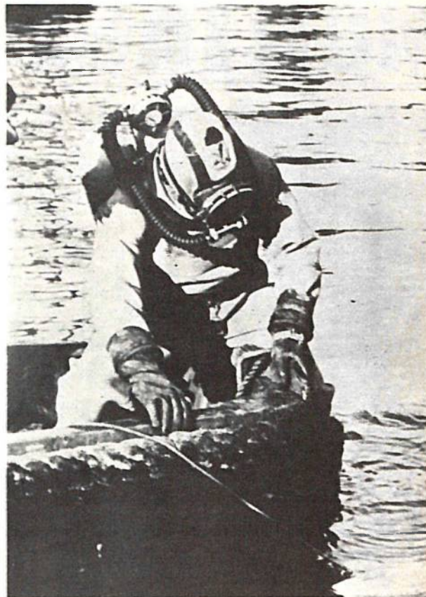
4. Ce plongeur, avant d'aller rejoindre son équipe, vérifie le coaxial d'antenne au fur et à mesure de son immersion.
