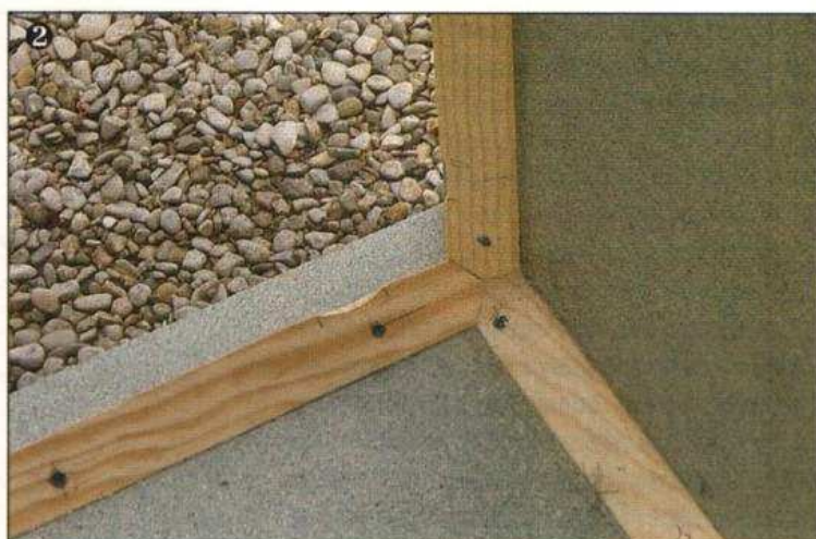
2 Les tasseaux sont fixés par vis et colle, on réalisera les coupes d'extrémité à 45° à la boîte à onglet. Pas très facile mais possible, nous l'avons fait, avec des tasseaux triangulaires.
