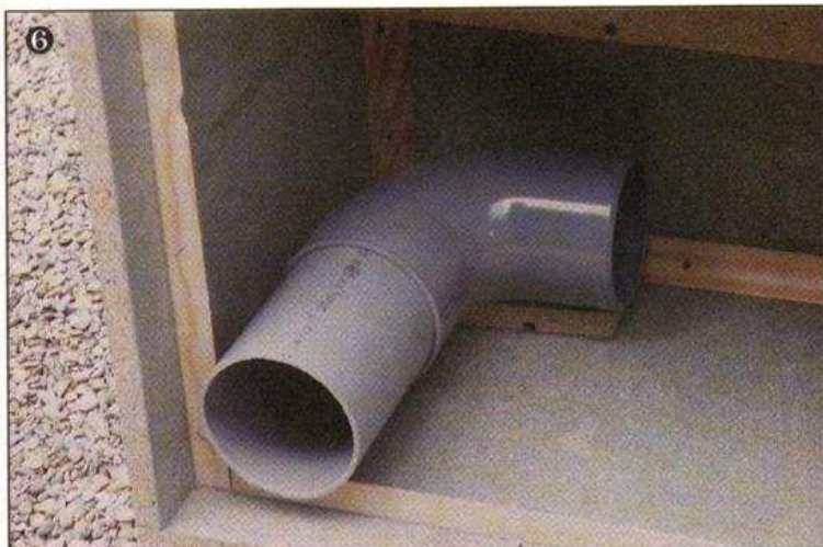
Installation de l'un des événements : une chute de 19 mm d'épaisseur, avec passage dans le bas pour un lien plastique, sert de support d'extrémité, les baguettes devront être ajustées au niveau des événements.
