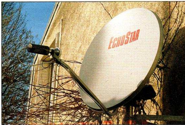
L'antenne installée ici sur un support mural, 80 cm de diamètre, tête triple bande.
