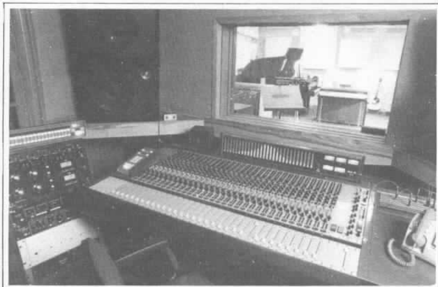
Fig 1 : Cabine de prise de son du studio « Le chien jaune ». Au premier plan, la console « plus trente ». Dans le fond, à travers la cloison de séparation (deux vitres parallèles et une vitre centrale placée de biais, en diagonale) on distingue le studio avec le piano « Stenway ».
