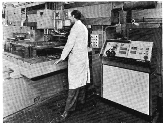
Photo n° 2 : Cette machine à percer, à fileter et à aléser a une commande numérique de position lui conférant une très grande précision de travail.
