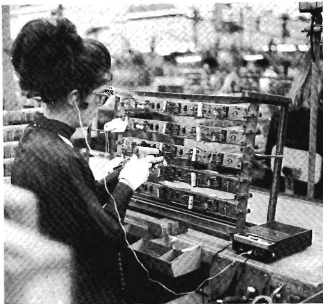
Photo n° 6 : L'ordinateur indique à l'opératrice les instructions de câblage sous forme orale.
