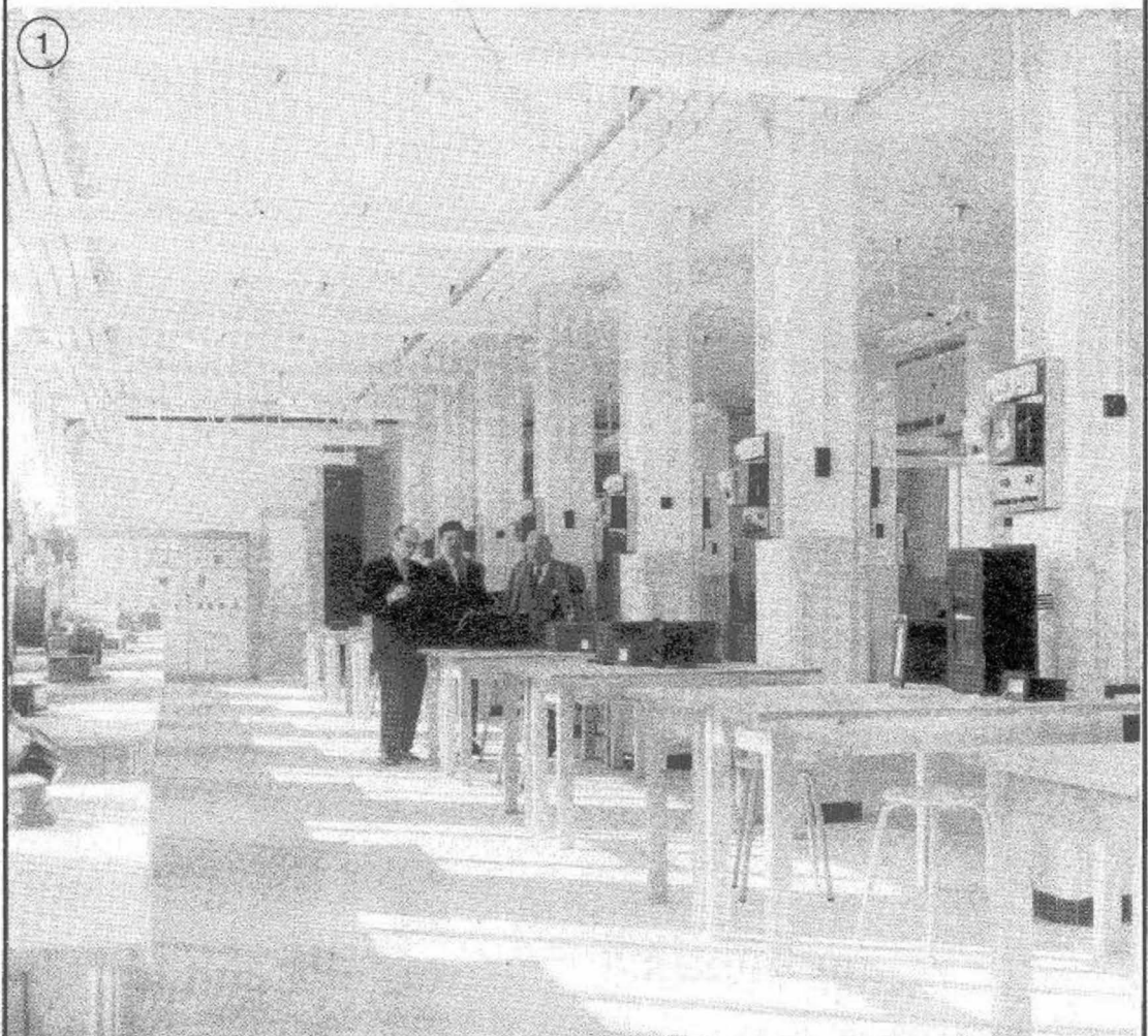
Salle de Mesures Electriques
